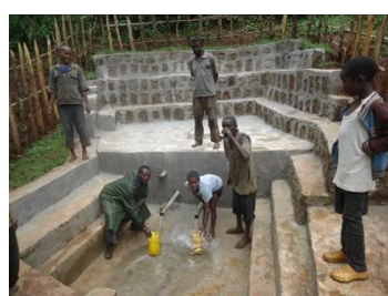
Obr. 25a: Vybudování zakrytého pramene, kebele Futahe.
